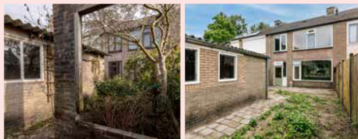
Raamkozijnen in de schuur voor (links) en na de renovatie (rechts)
