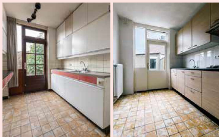
Keukenblok en achterdeur voor (links) en na de renovatie (rechts)
