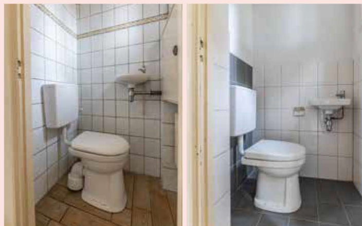
Toiletpot fontein en toiletreservoir voor (links) en na de renovatie (rechts)
