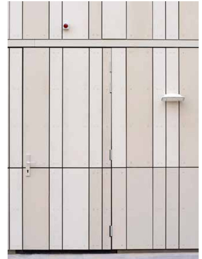
Kerloc is inmiddels op grote schaal beschikbaar voor het realiseren van onder meer ventilerende gevelbekleding met brandklasse A2.
