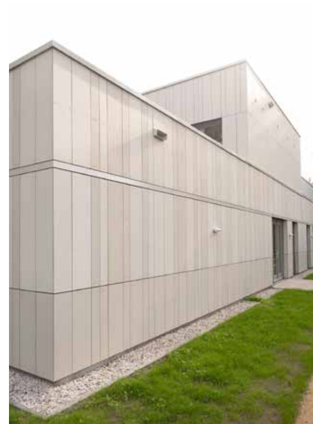
Kerloc Circular Ceramics: keramische gevelbekleding, gemaakt door het verstenen van hout.
