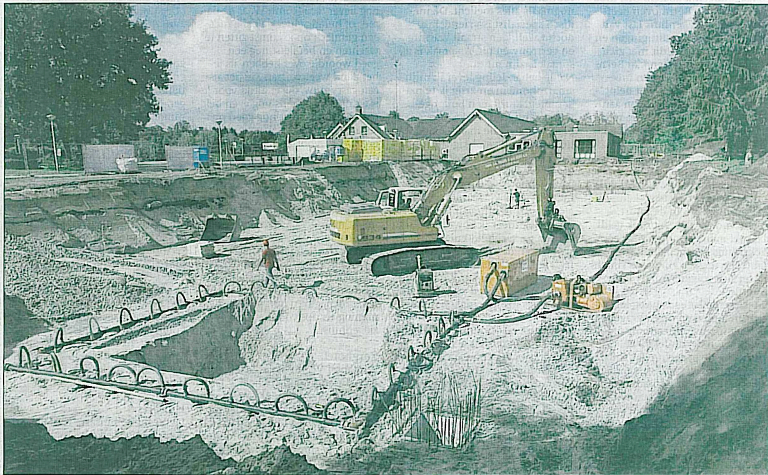
Aan de Bedafseweg in Uden is dinsdag begonnen met het afgraven van het terrein waar het hotel en bowlingcentrum van De Vrije Teugel komen. Op de achtergrond staat het oude gedeelte van het party- en evenementencentrum. foto Dolph Cantrijn
