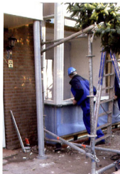
Met een kraan op de vrachtwagen is de erker snel en soepel op zijn plaats te zetten.
