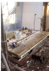
De bouwers monteren stellingen tegen het binnenspuwblad en op de vloer.
