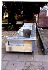
Bij de tweelaags erker wordt het geprefabriceerde dakelement actueel gemonteerd.
