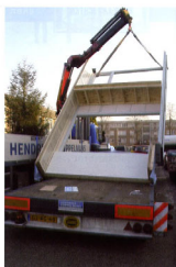
De tweelaags erker werktijd stijfheid door de tijdelijk gemonteerde vloer.
