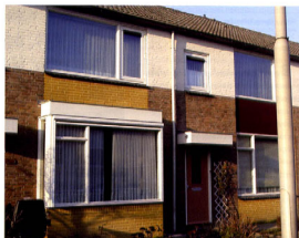
De borstering boven eengelaags erkers wordt van tevoren gemetseld op een nieuwe laterl, met koudebrugonderbreking en loodlabbe.
