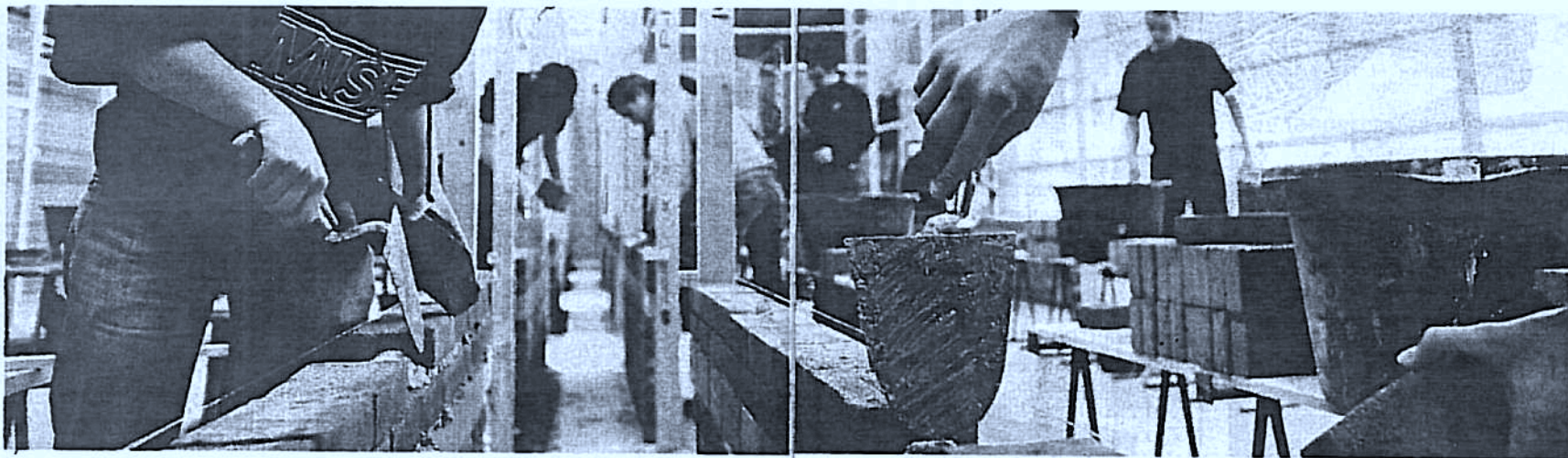
Hanneke Godfroy: "Je ziet metselaars aan het werk en denkt: dat valt wel mee. Maar in de praktijk valt het flink tegen". Foto: Dolph Cantrijn
