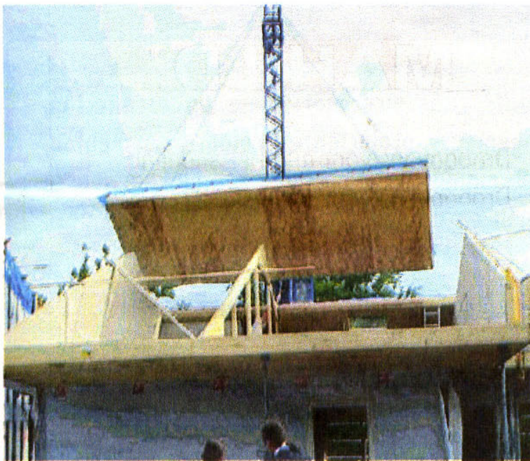
Het optoppen zit volgens huisvestingsadviseur houtconstructies Dennis Kerkhof in de lift.
