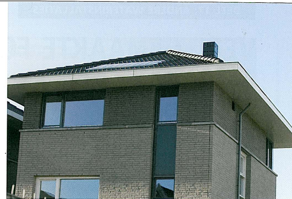
Gekozen is voor andere zonnecollectoren, want de afmetingen van de beoogde collectoren waren minder geschikt voor montage op dit dak.
