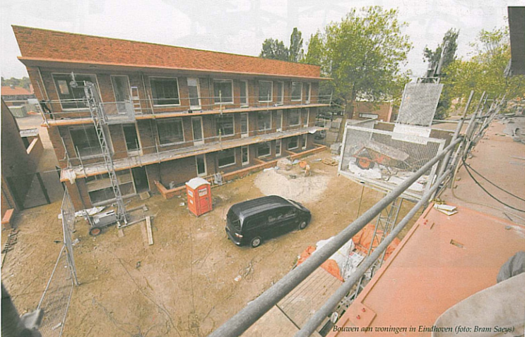
Bouwen aan woningen in Eindhoven (foto: Bram Smeets)
