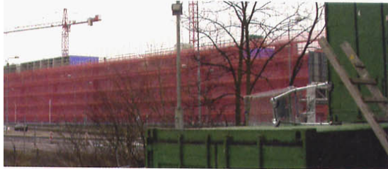
Bouwfase tijdens optoppen
