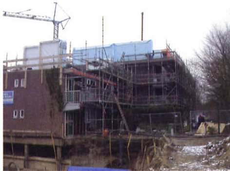
Optoppen houtskeletbouw, Raamsdonksveer
