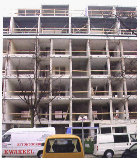
Gestripte flat met dubbele optopping staalraambouw
