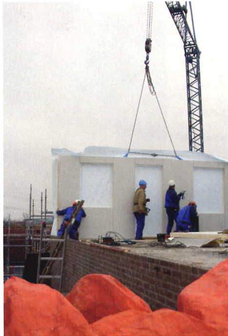
Plaatsing gevelpaneel houtskeletbouw (Lutteldonk, Raamsdonksveer)
