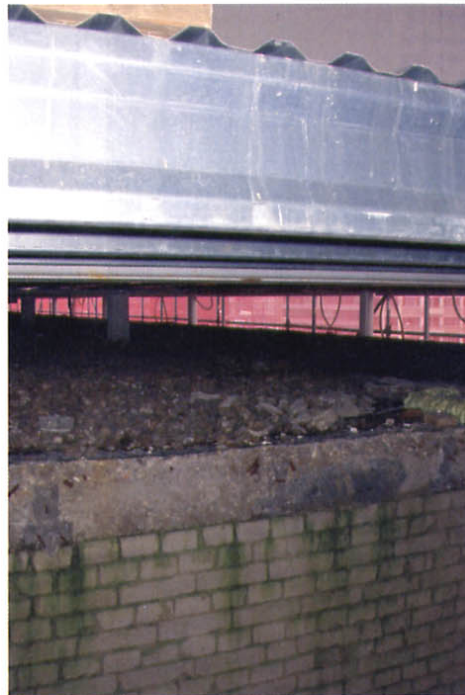
Kruipruimte tussen oorspronkelijk dak en nieuwe vloerconstructie (staalframebouw)
