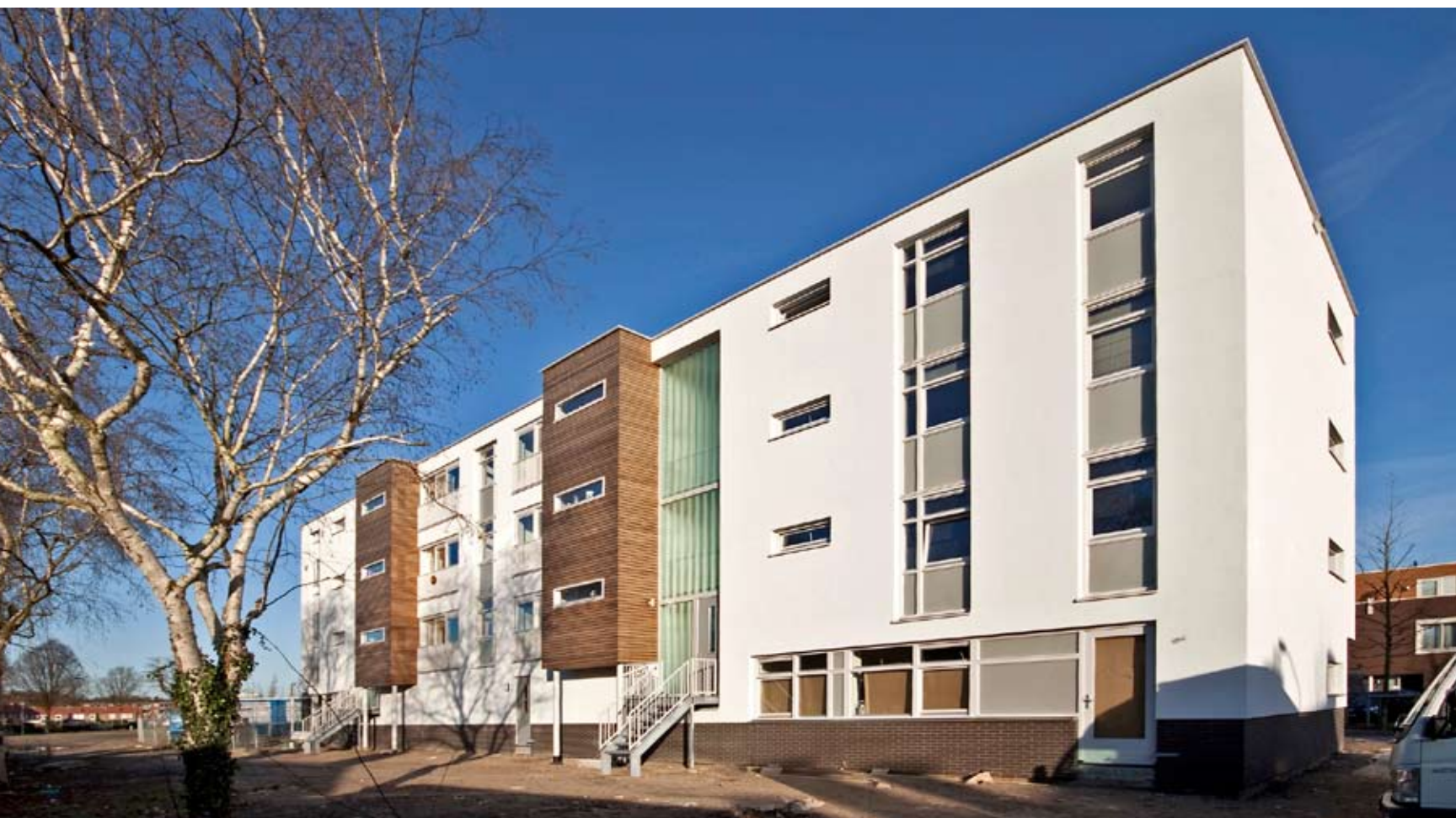
Tuingevel (achtergevel) na de renovatie
